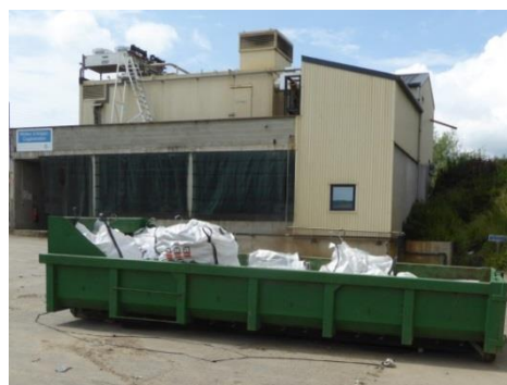
Container con rifiuti di amianto, Fonte: A2Conseils sprl
