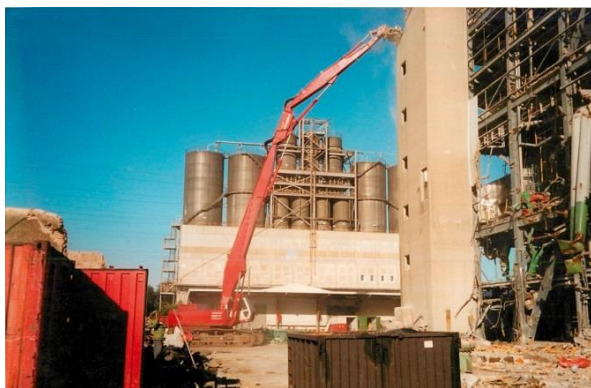
Cantiere di demolizione. Fonte: VERAS
